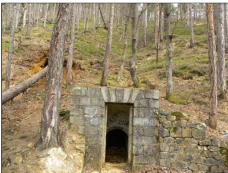
Slika 71: Kaptažni objekat izvora mineralne vode Guber kod Srebrenice
